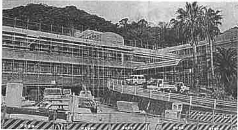
順調に工事が進んでいます
