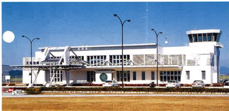
天草空港ターミナルの全容
