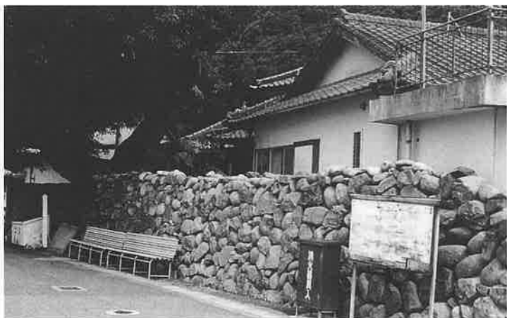
牛深市魚貫町池田地区の魚貫崎海岸の石垣 海岸に面するこの地区では、風除けのための石垣が多くみられる。
