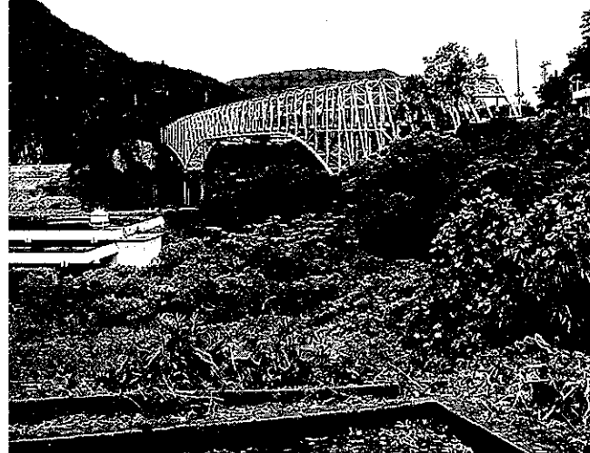
天草五橋のうち1号橋
